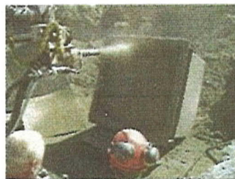
喷射混凝土
